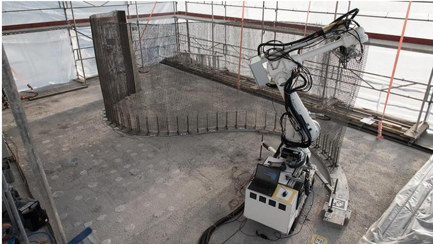
Abb 30: Bauroboter im Dfab
